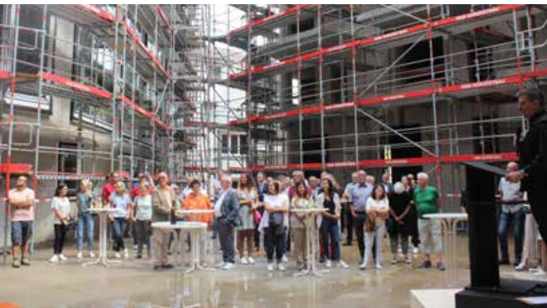
Wohnbau-Geschäftsführer Horst Riess (vorne am Pult) begrüßte über 100 Gäste zum Richtfest des Großbau-Projekts „Drei-Kronen-Hof“ in der Tuttlinger Innenstadt.
